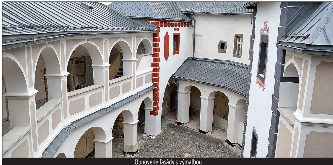
Obnovené fasády s výmalbou
