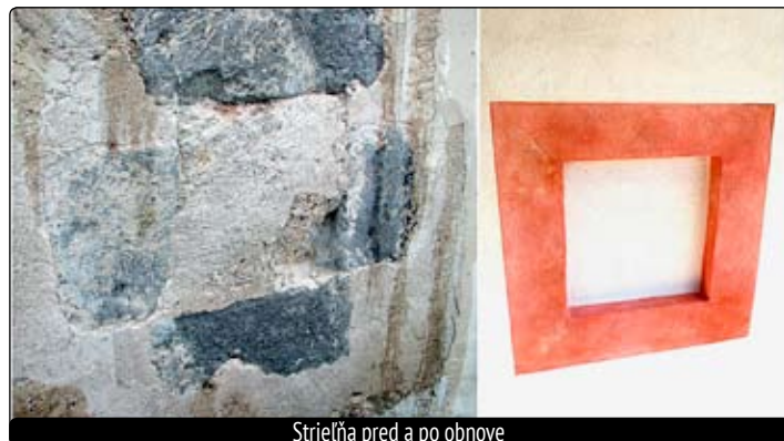
Strieľňa pred a po obnove
